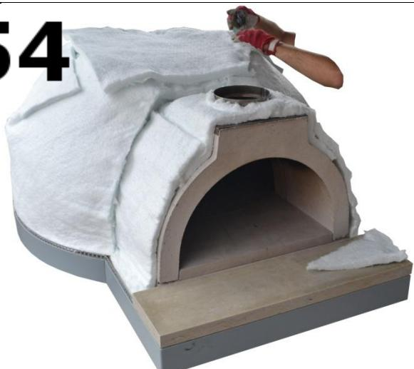
Přebytečné kusy rohože, lze odstříhnout pro lepší tvarovatelnost kopule kamnářskou maltou Haftákem.
