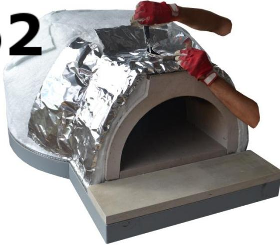
Po nanesení třetí vrstvy izolační rohože Silcawool, položíme na tyto vrstvy AL silnou hliníkovou fólii.
